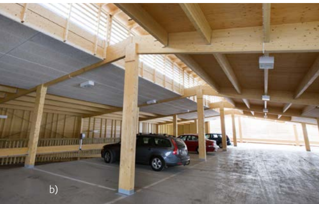
Figure 8.8 a) Block of houses, Uppfinnaren in Växjö. b) Car park Ekorren, Skellefteå.
